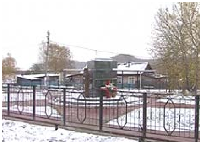
Фото завершения работ
