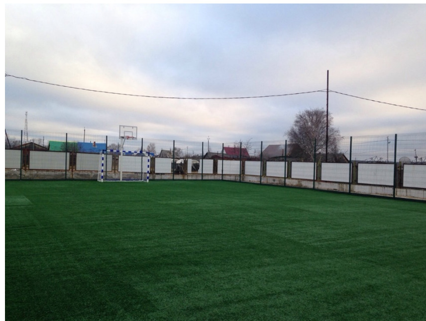
Фото завершения работ
